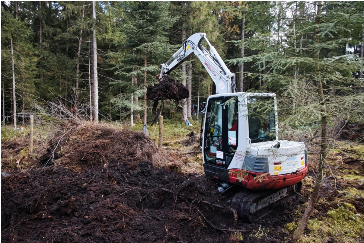
Bild 3: Minibagger im Einsatz
