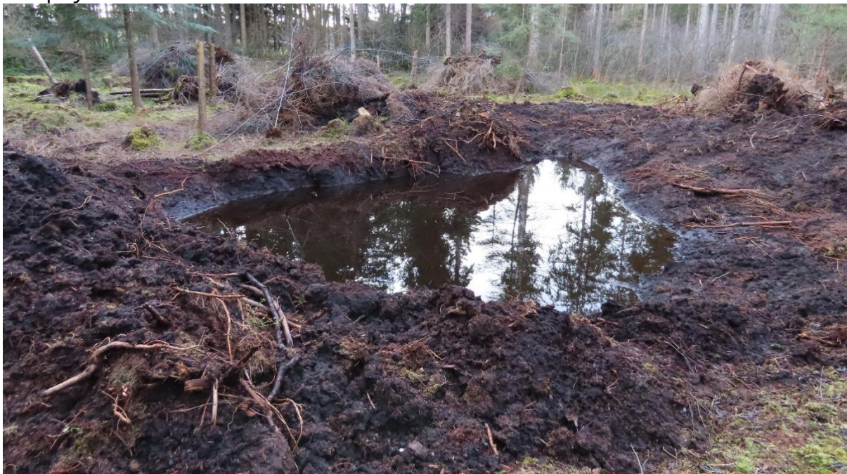
Bild 5: Der neu angelegte Weiher ein paar Wochen nach dem Baggereinsatz
